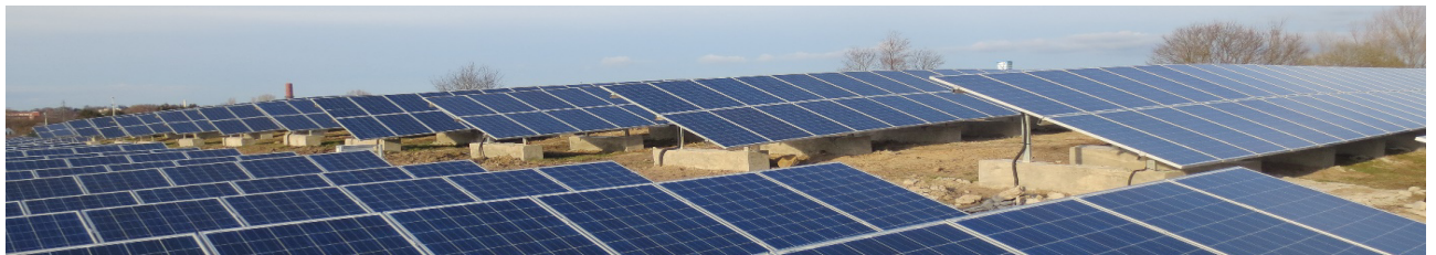
Wariant z dwoma modułami ustawionymi pionowo jeden nad drugim i systemem o dwóch nogach
